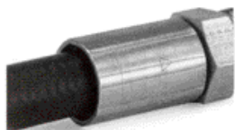
Falta de agarre de la Conexión
