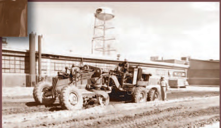
Vista panorámica de la construcción de la Planta Toluca.
